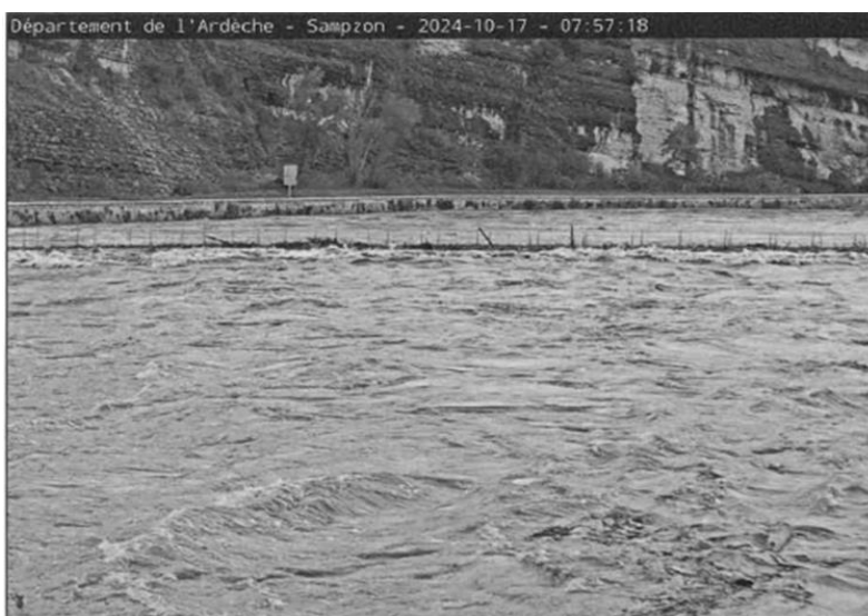
Le 17 octobre 2024 à 8h du matin : Le pont est totalement submergé.
