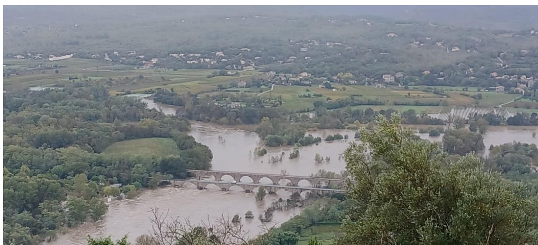
La crue du 17/10/2024 aux ponts de La Bastide
